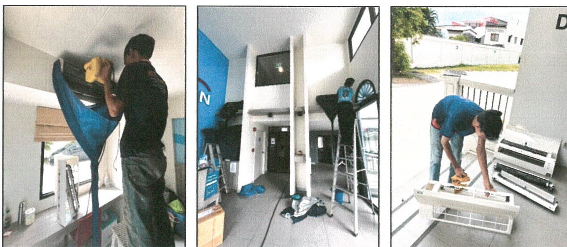
รูปภาพที่ 2.23 การล้างเครื่องปรับอากาศ
