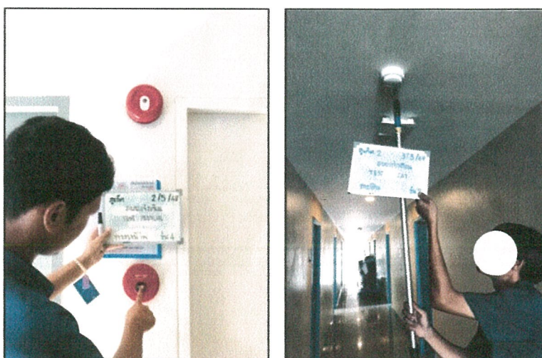
รูปภาพที่ 2.32 การตรวจสอบระบบป้องกันและเตือนอัคคีภัย
